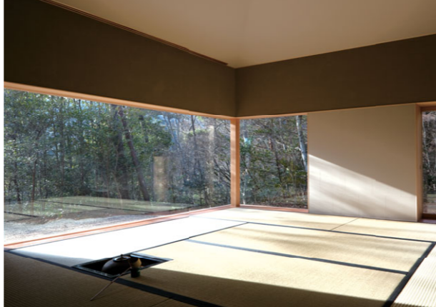
強度の高い屋根構面による開放的な空間
