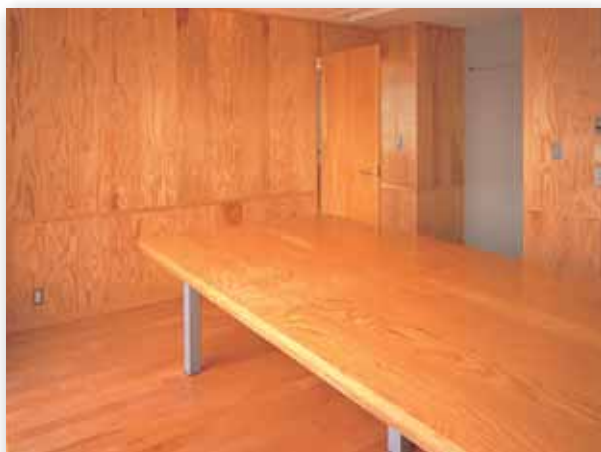
秋田県産材合板を利用し、東京都にて施工
