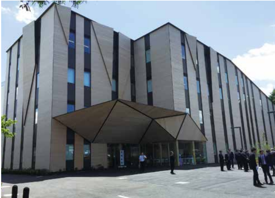
外観 (木造4階建て)
