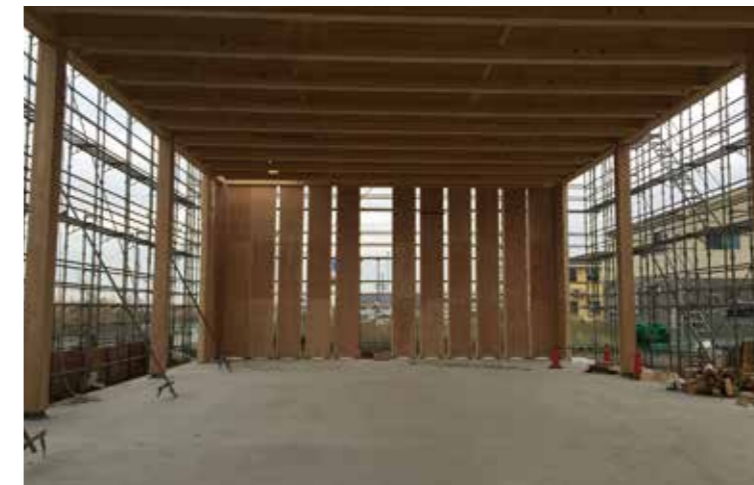
厚物構造用合板による耐力壁と水平構面の施工現場
