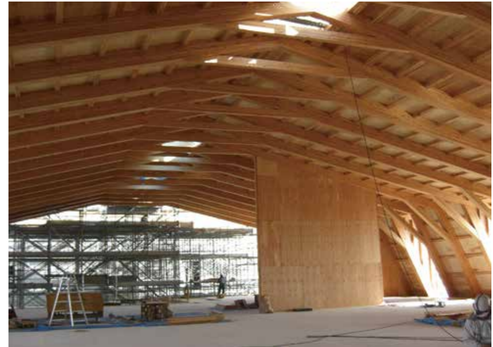
厚さ24mm構造用合板による耐力壁と屋根構面の施工現場
