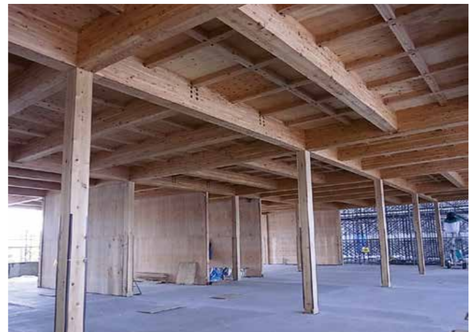
厚さ24mm構造用合板による耐力壁と床構面の施工現場
